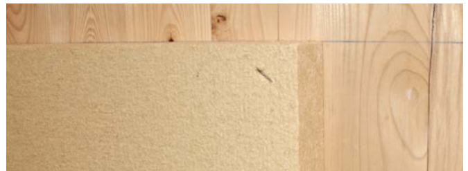
Erste Plattenreihe an waagrechter Schlagschnur ausrichten.
