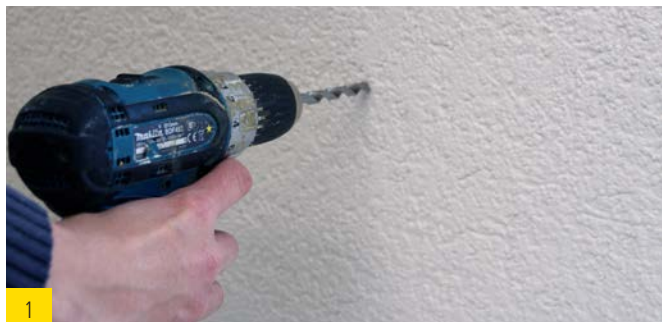
1 Verputzte Holzfaser-Dämmstoffplatte mit 8 mm-Holzbohrer vorbohren.
