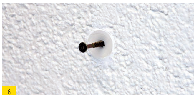
6 Mit 4–5 mm-Schraube Anbauteil befestigen.
