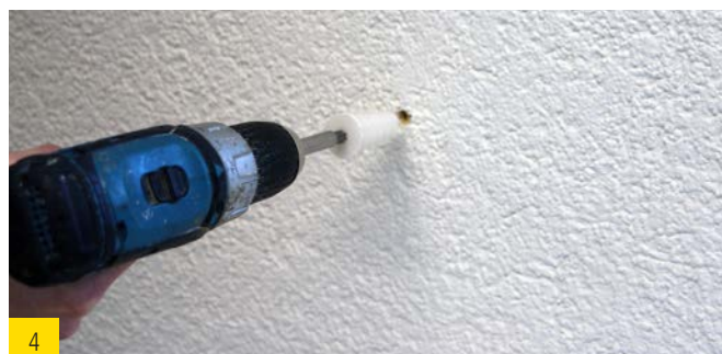
4 Spiraldübel mit TORX T40 oberflächenbündig mit verputzter Holzfaser-Dämmstoffplatte eindrehen.
