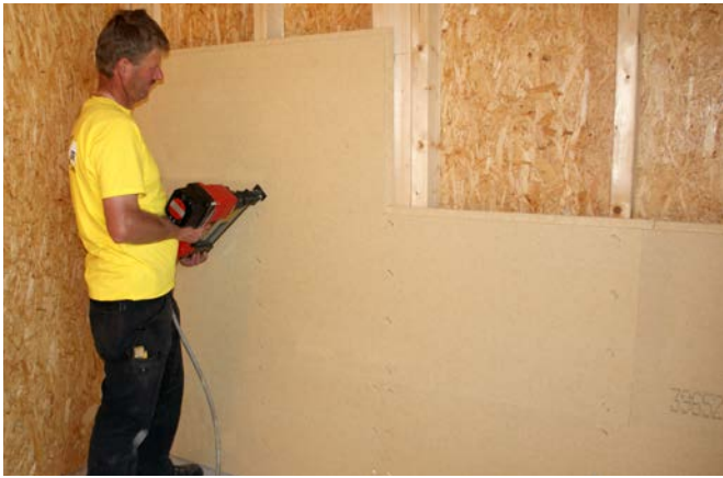
Befestigung mit Breitrückenklammern.
