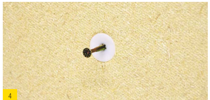
4 Mit 4–5 mm-Schraube Anbauteil befestigen.
