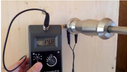
Holzfeuchte Holzständerkonstruktion \leq 18\% .
