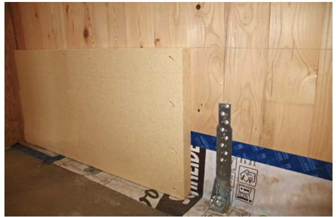
Erste Plattenreihe an waagrechter Schlagschnur ausrichten.
