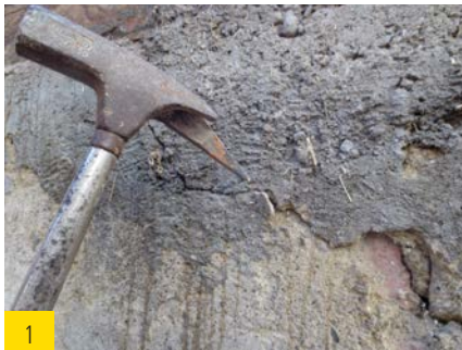
1 Lose Putzschichten entfernen.
